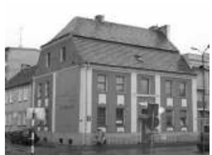
Budynek przy ul. Niepodległości 16 - po pożarze
