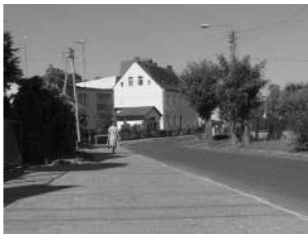
Remont chodnika ul. Tunelowa
