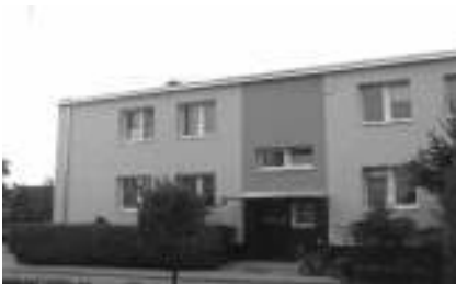
Budynek Wspólnoty Mieszkaniowej przy ul. Tunelowej 56a/A
