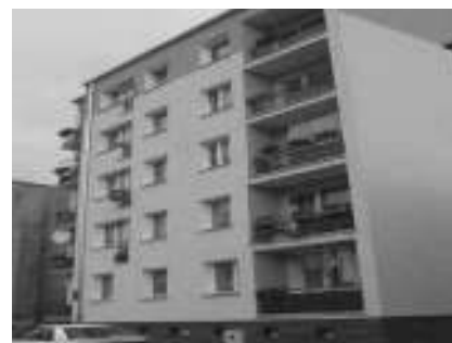
Budynek Wspólnoty Mieszkaniowej przy ul. Różanej 1
