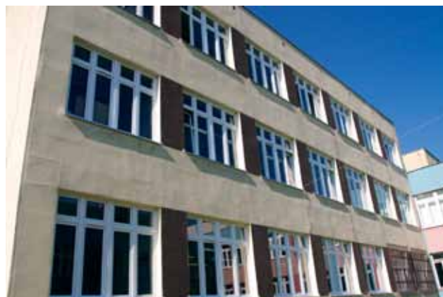
Wymienione okna w PG 2
