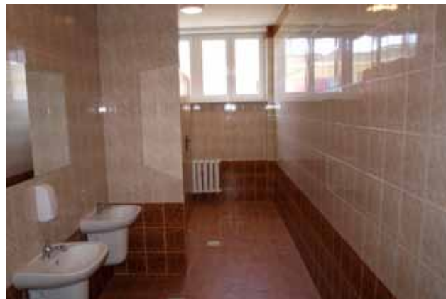
Wyremontowane toalety w PG 2
