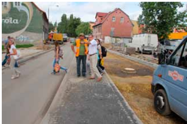
Modernizacja drogi nr 156
