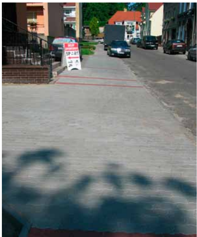
Nowe chodniki przy ul.Koziej
