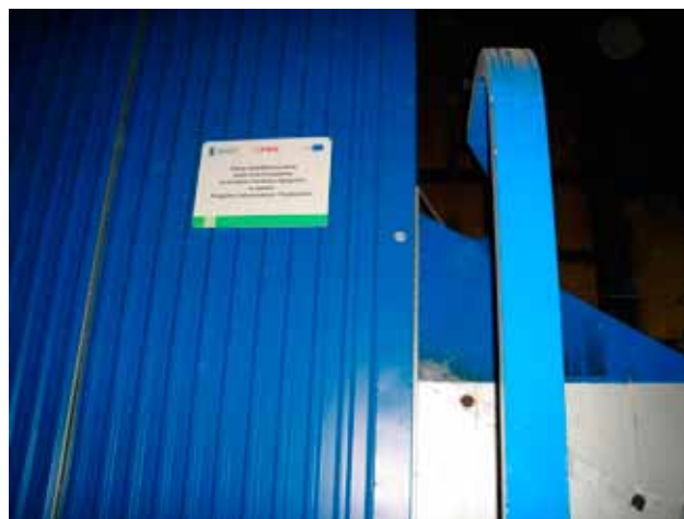
Modernizacja ciepłowni- nowy kocioł WR-8
