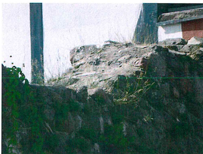
Fot.3 Górna partia muru zamknięta cementem.
