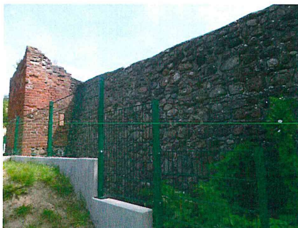
Fot.31 Widok na mur od strony boiska, rozwarstwienia korony murów czatowni
