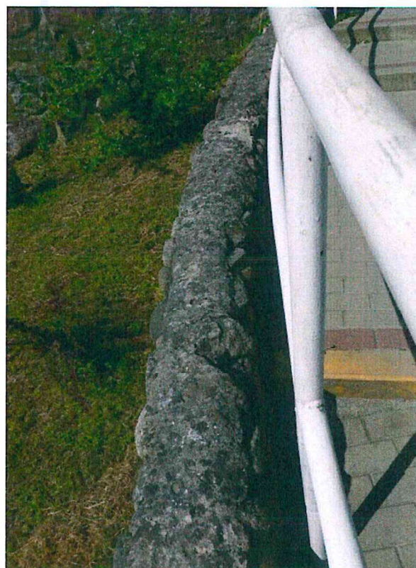
Fot.15 Zamknięcie muru cementem
