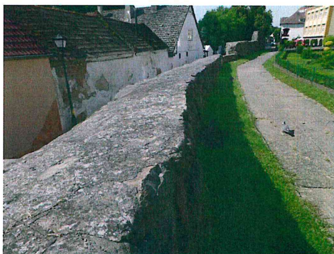
Fot.8 Zamknięcie muru od góry cementem
