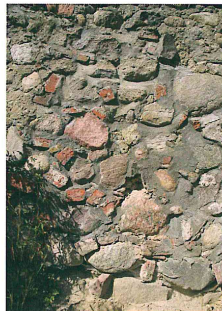
STAN TECHNICZNY MURU (UBYTKI/SZCZELINY/SPEKANIA) (rejon odkrywki "1")
