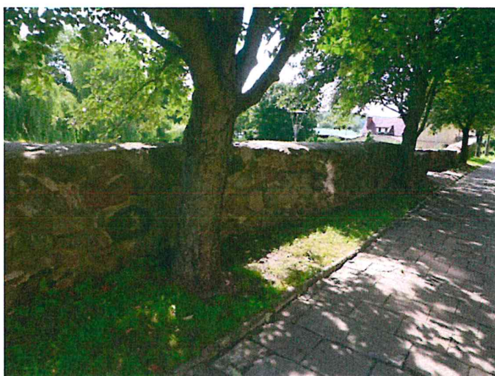
Fot.17 Drzewa rosnące zbyt blisko muru wymagające przekierowania korzeni
