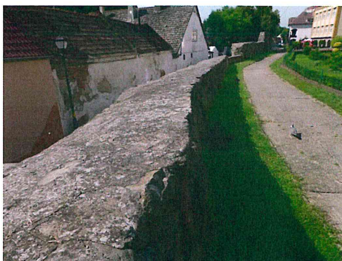
Fot.8 Zamknięcie muru od góry cementem
