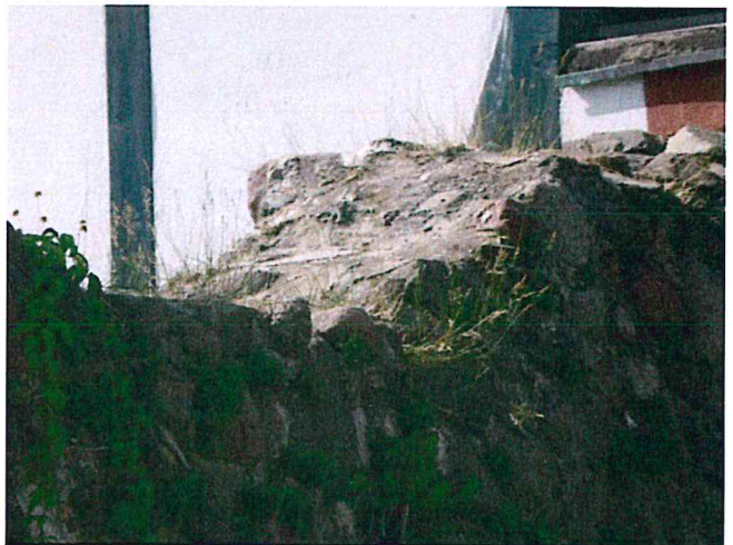
Fot.3 Górna partia muru zamknięta cementem.
