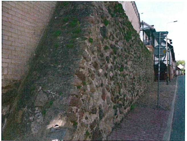
Fot.2 Zamknięta cementem korona murów.
